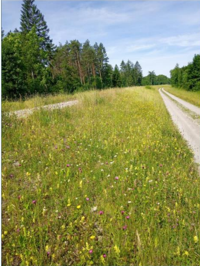
Abb. 66: Kalk-Magerrasen auf der landseitigen Bö- schung eines Isar-Dei- ches bei Bruckberg in Niederbayern
