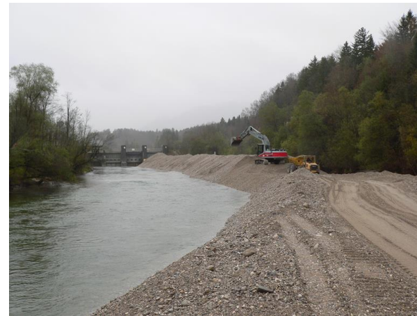
Einbringung Kies-Depot unterhalb Kraftwerk
