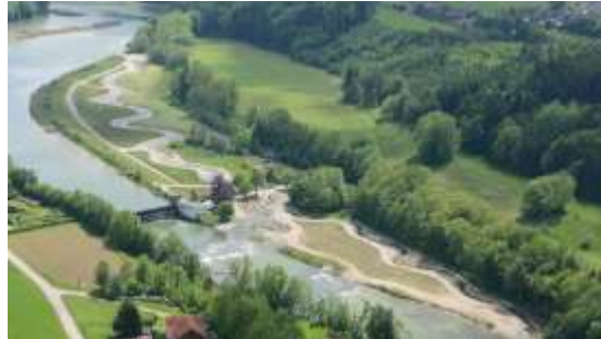
Illerstufe 7 Maria Steinbach mit Umgebungsgewässer Uferaufweitung, Bildnachweis :LEW
