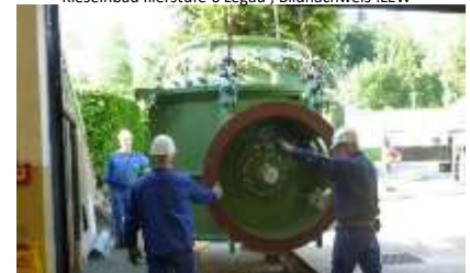
Einbau Dotationsturbine Illerstufe 6 Legau , Bildnachweis :LEW
